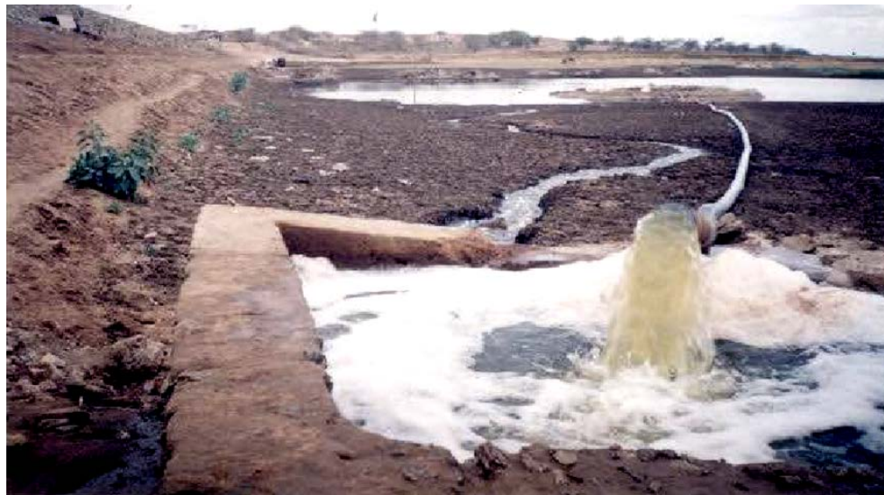
Figura 7. Uso de poço construído dentro Açude Manoel Marcionilo, em Taperoá-PB, em 1999. Fonte: Ronilson José da Paz (março de 1999).
