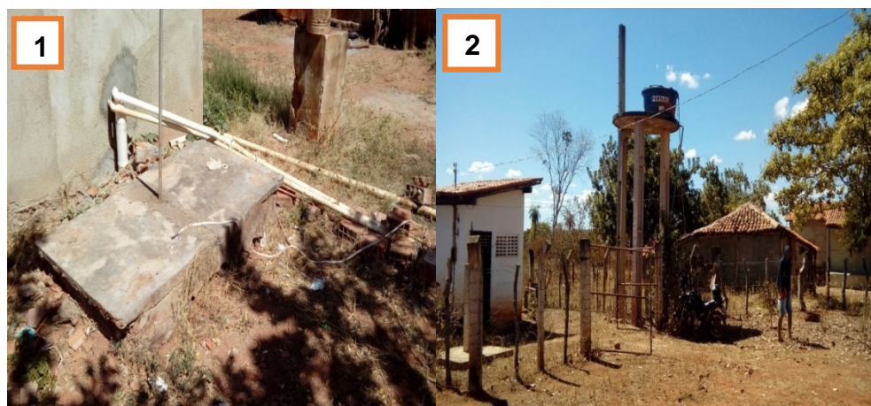
Figura 3. Fossa Negra próxima ao Poço Artesiano da Localidade Angico (A) e Distância entre a residência (P1) e o local de proteção do poço artesiano.
